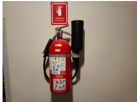
รูปที่ 20 ดับเพลิงแบบมือถือ
